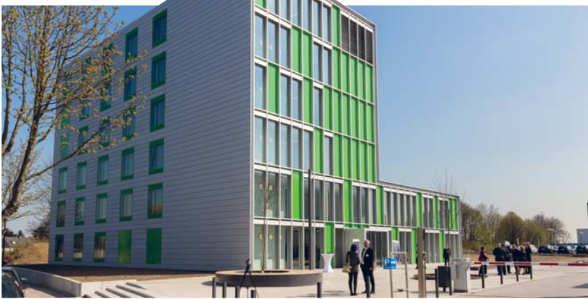
Auch optisch setzt der LogistkCampus Akzente: Das sechsstöckige Gebäude ist perfekt auf die TU Dortmund abgestimmt. Foto: Roland Baege
